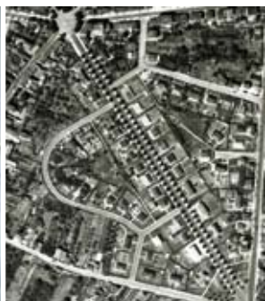
FIG. 4. Vue aérienne vers 1952 (AD de la Seine-Saint-Denis).
