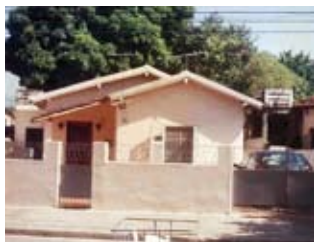
FIG. 7. Maison Minas - M [2001] © Collection Mario Trompowsky.
